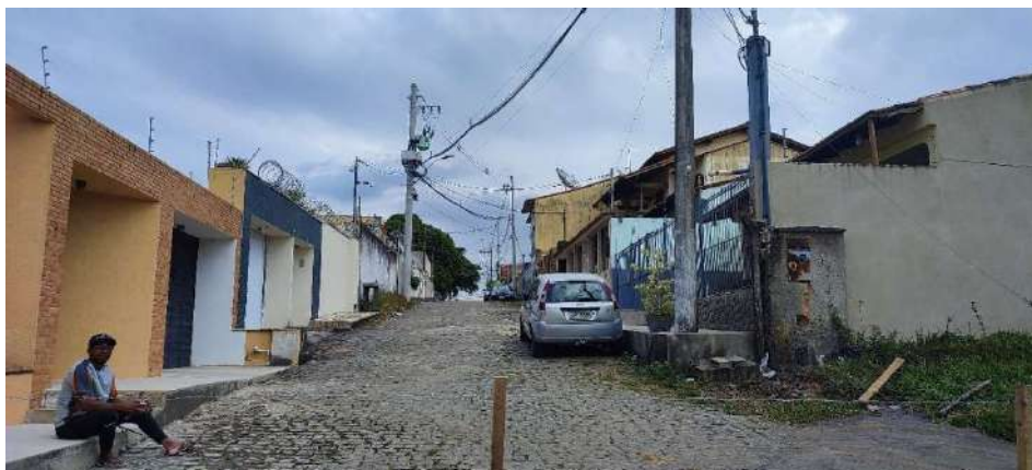
Figura 25 – Trecho final da Rua Espírito Santo, no acesso ao pátio de carga e descarga do empreendimento.
